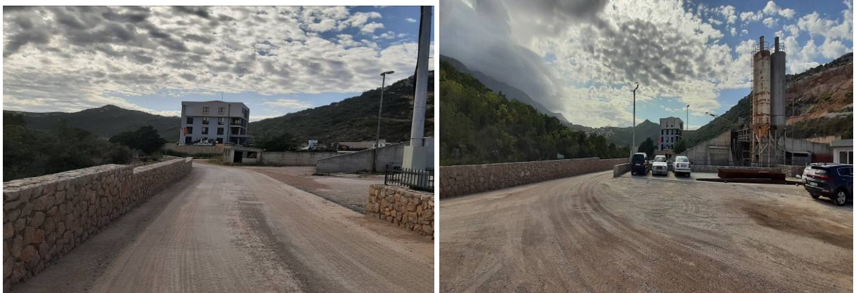
Sl. 2.5 – 2.6. Pristupna saobraćajnica i pristupni plato
